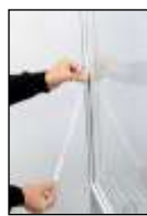
▲ フレームに反射材を貼る
